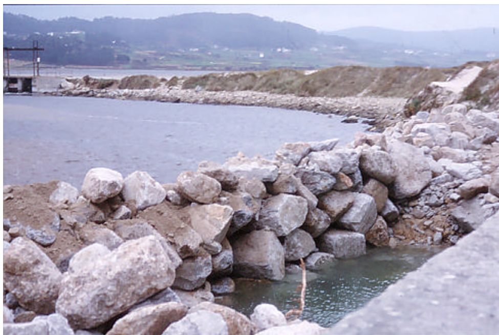
Fotografía 1 Muro de contención tipo escollera en Baldaio.
