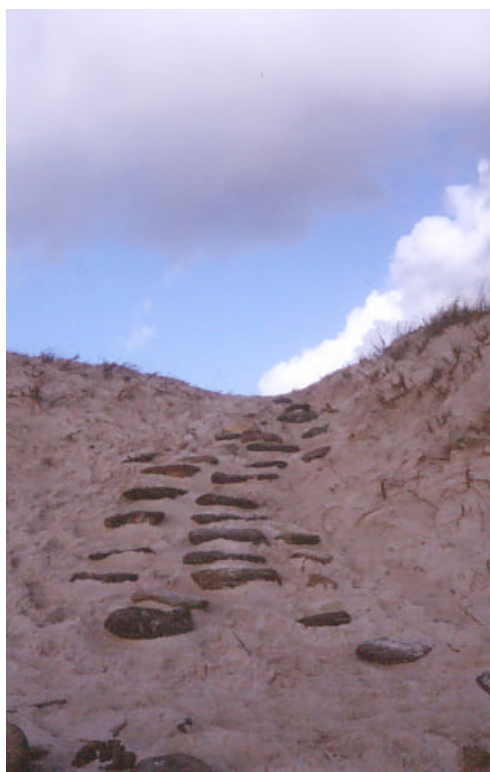
Fotografía 8 Ejemplo de un acceso entre dunas a la playa de Louro, empedrado por los propios voluntarios para facilitar su circulación, y que contribuye a la estabilización de la duna.
