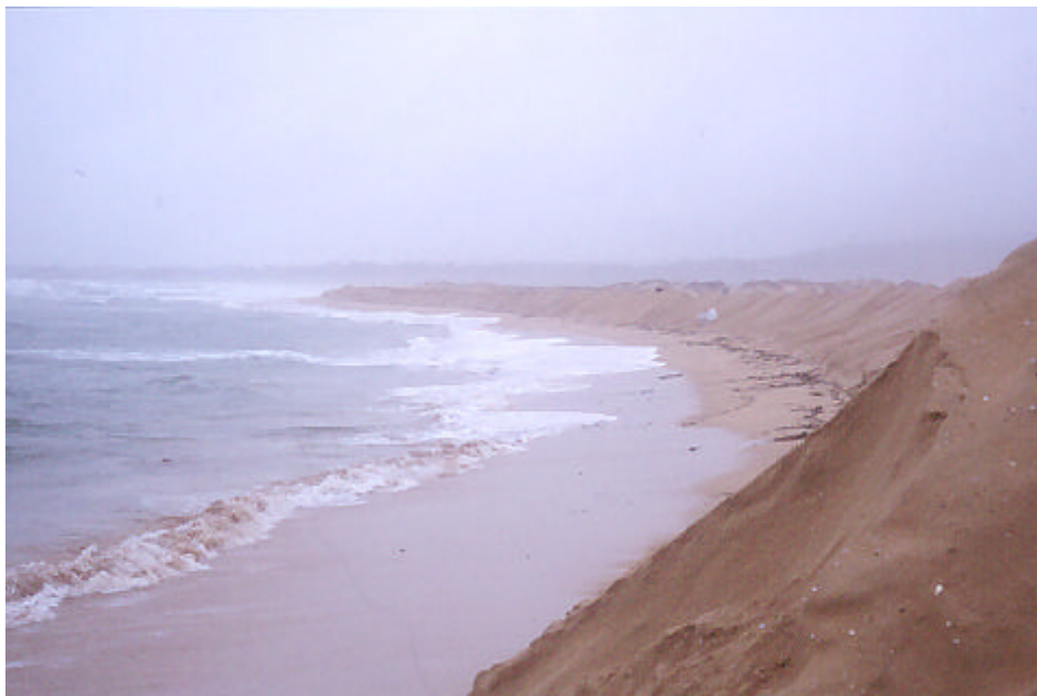
Fotografía 3 Emplazamiento de una barrera de arena (medida complementaria) en la playa de Corrubedo para evitar la entrada del fuel en la marisma.
